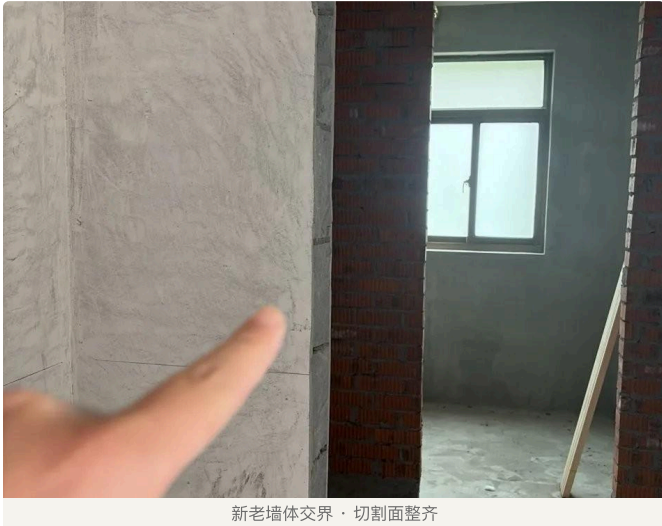
新老墙体交界·切割面整齐
