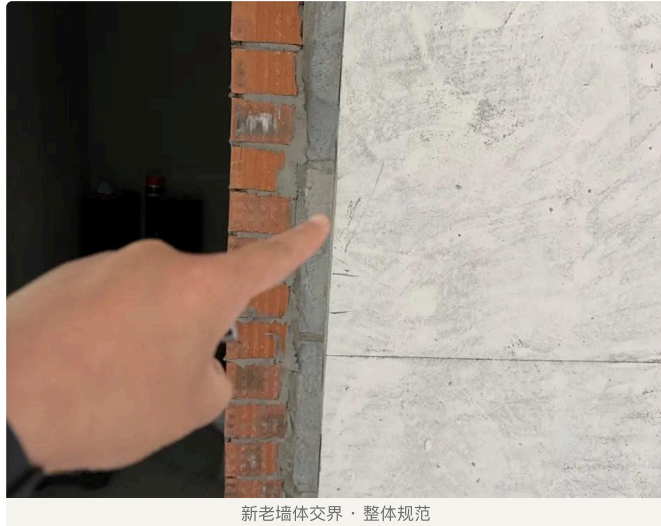
新老墙体交界·整体规范
